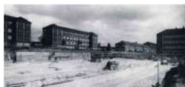
La Cité scolaire en construction
